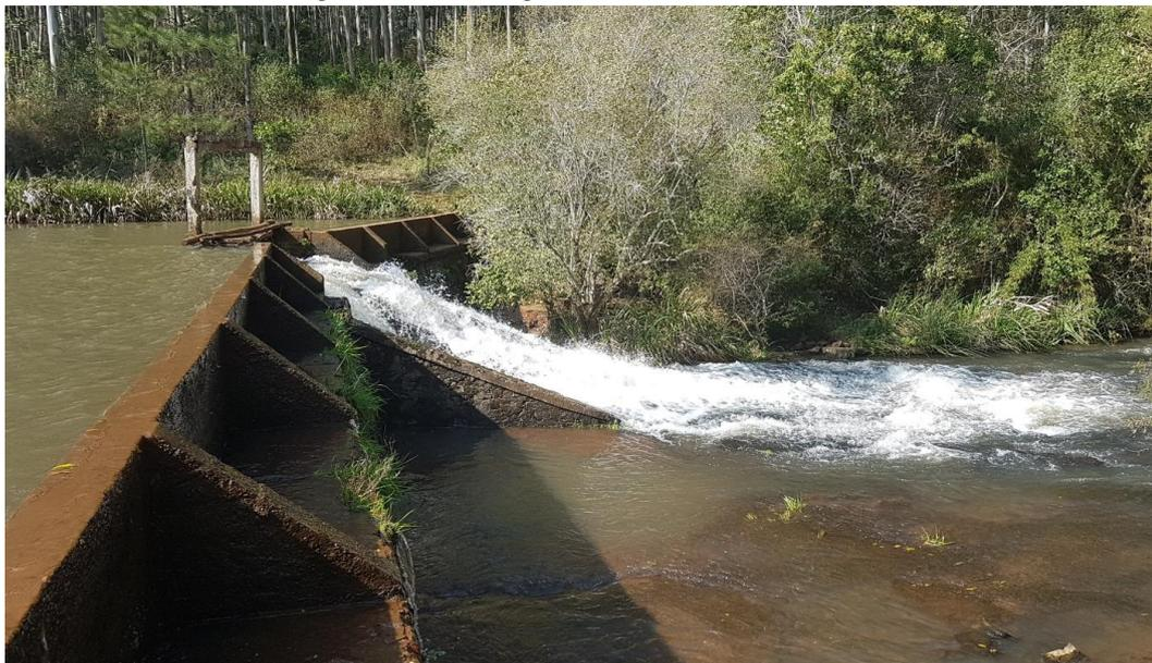
A estrutura, quando reformada, terá 50m de extensão medidos pela crista, e será composta pelos seguintes módulos, descritos da margem esquerda para a direita.
