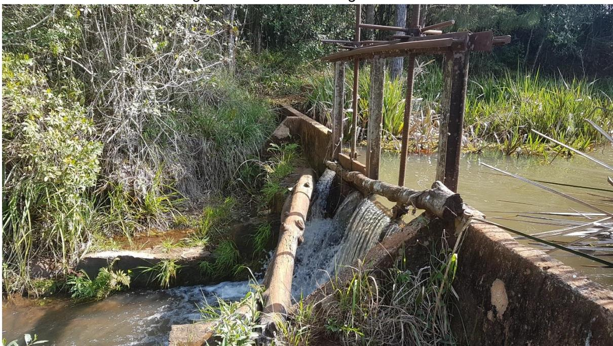
Visto que a tomada de água existente não contempla todos os requisitos necessários para garantir a segurança do circuito hidráulico uma nova tomada de água será construída a jusante da tomada de água existente para permitir a instalação de novas comportas, limpa grades e fazer a transição para o canal de adução.
